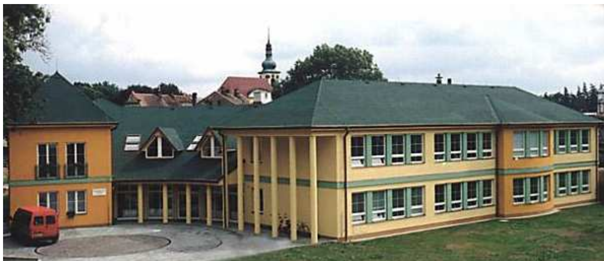
Budova SŠ potravinářské Smiřice
